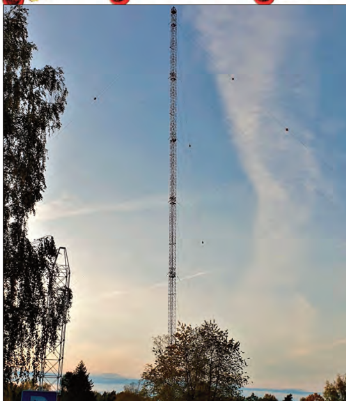
Der letzte noch vorhandene 210 m hohe Antennenmast
